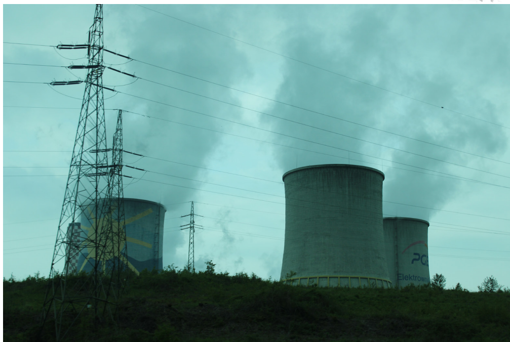
Widok elektrowni (for. Piotr Lewandowski)
